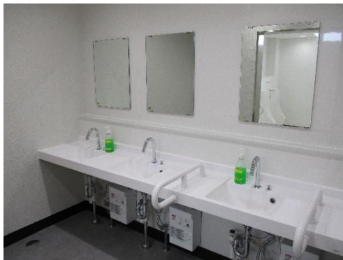
改修したトイレ
